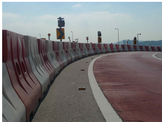
<그림 5.9> PE 울타리 설치 예
